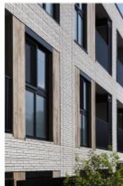
外観写真（2023年9月撮影）
