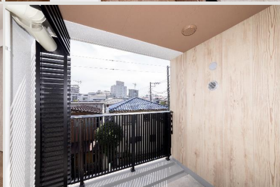
305号室室内写真【2025年6月撮影】
