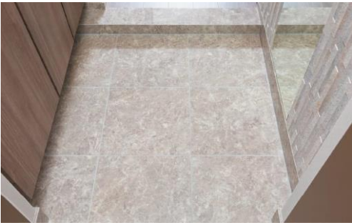
石調タイルの玄関床
