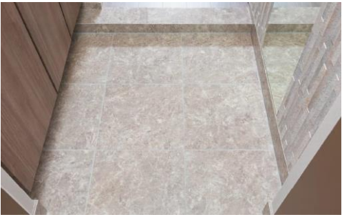
石調タイルの玄関床
